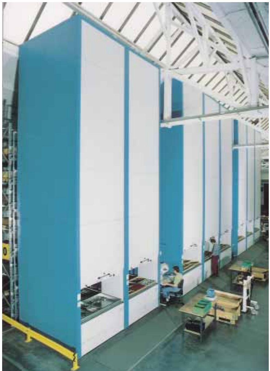
Kommissionierung von Ersatzteilen aus Liftsystemen
